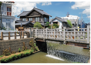
〈樋橋: ジャーガー橋〉
